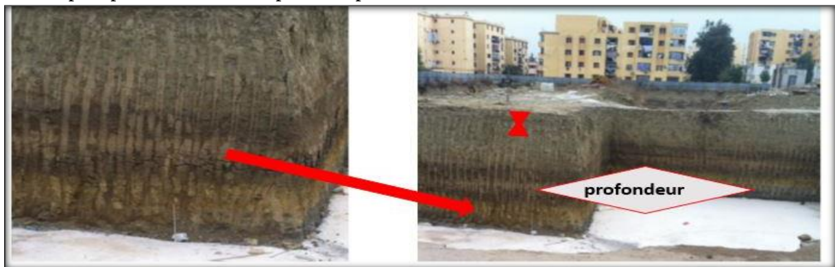
Figure 45 : Stratification horizontale et bien structurée, aspect et apparence différents dus à l'humectation et l'altération .source : POS N01Boufarik
