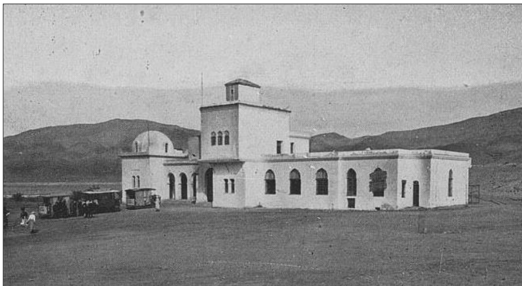
Figure 6. 37: Hammam-Salahine- Vue d'ensemble Source : Hanriot, M., 1911, p.
