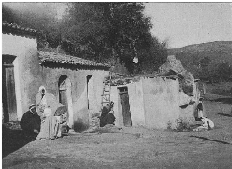
Figure 7. 28: Hammam-Berrouaghia : L'établissement Source : Hanriot, M., 1911, p.148
