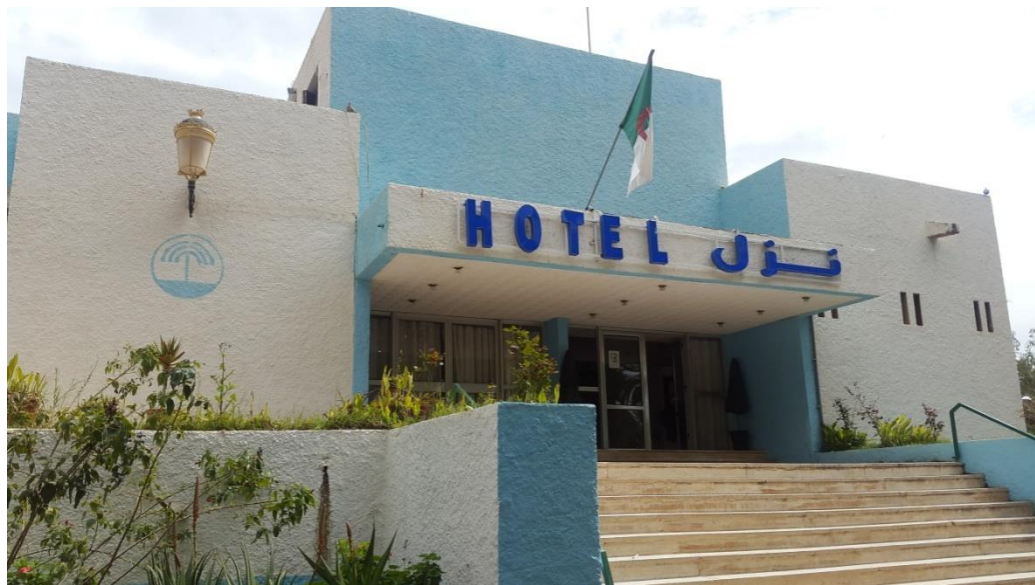
Figure 4. 52: La façade principale de l'hôtel Source : Auteur
