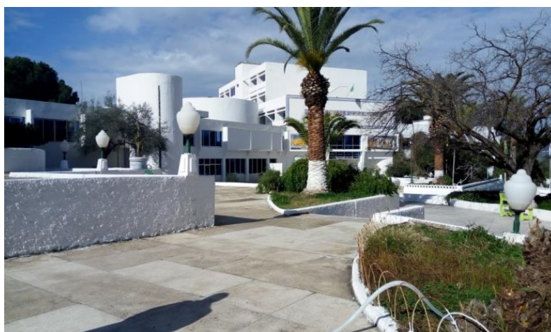
Figure 4. 34: Hammam-Chellala : Vue sur l'hôtel Source : Auteur
