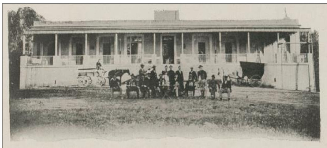
Figure 4. 41: Hammam Bou-Hadjar- Hôtel des bains- Façade principale Source : Paris, P., 1909, p.101
