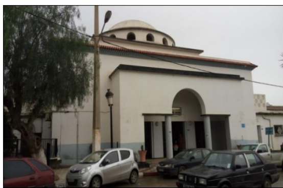
Figure 6. 31: Entrée principale des bains
