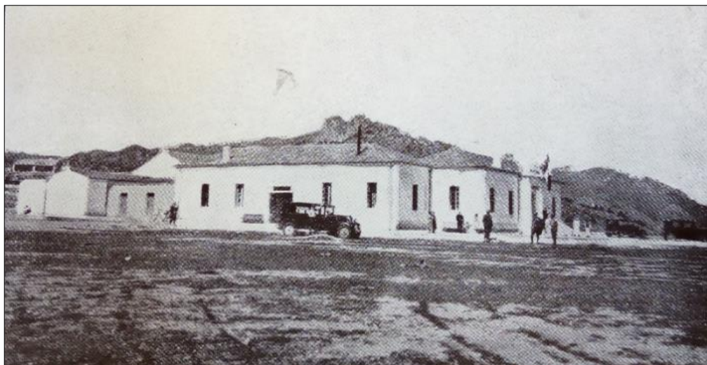
Figure 7. 38: Station thermique des Biban : « Vue d'ensemble » Source : Arnaudies, F., n.d, p.31
