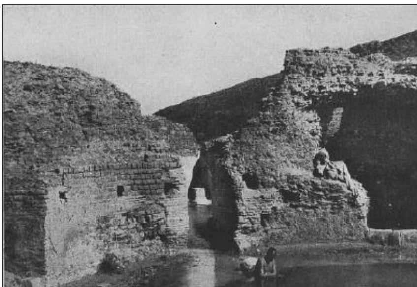
Figure 6. 2: Hammam des Amamrhas : La piscine circulaire Source : Hanriot, M., 1911, p.230
