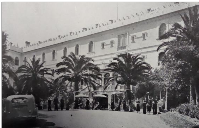
Figure 5. 6 : Hammam-Righa : L'entrée du Grand Hôtel Source : DAPREMONT. J., s.d, p.20
