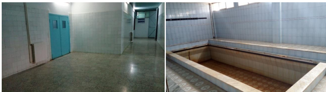
Figure 4. 16: Vues intérieures de l'établissement thermal
