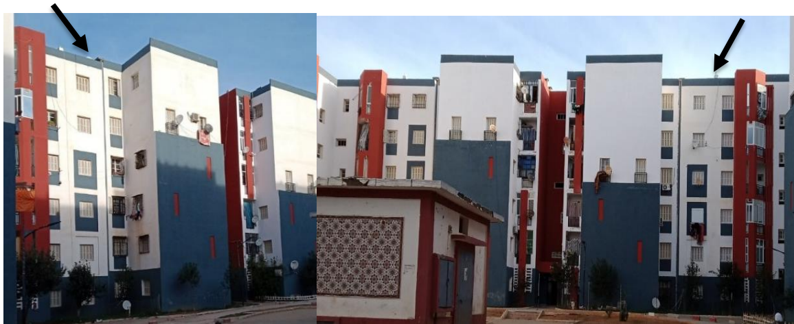
Photo 1 et Photo 2 : Le bâtiment investigué (Source : auteur, le 9 janvier 2022)
