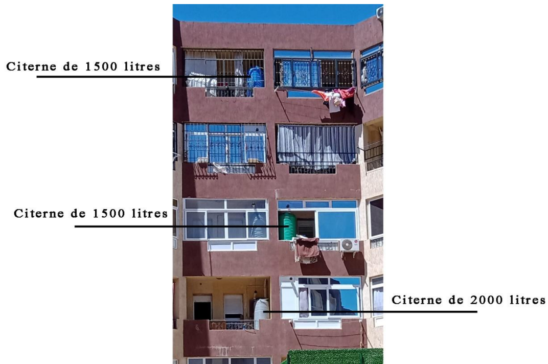
Photo 9 : L'installation d'un dispositif de stockage dans les balcons Du bâtiment investigué
