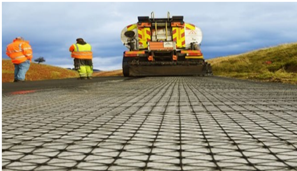
Figure III.6- Mise en place de la grille Tensar
