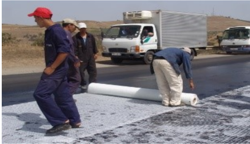
Figure III.7- Géogrille en fibres de verre et membrane non tissée
