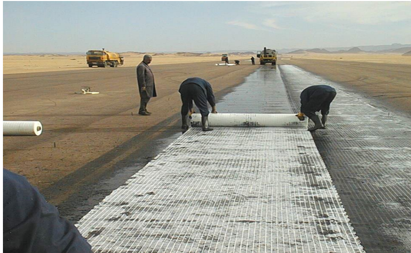
Figure IV.5- Placement du rouleau de géo-grille après insertion de l'émulsion
