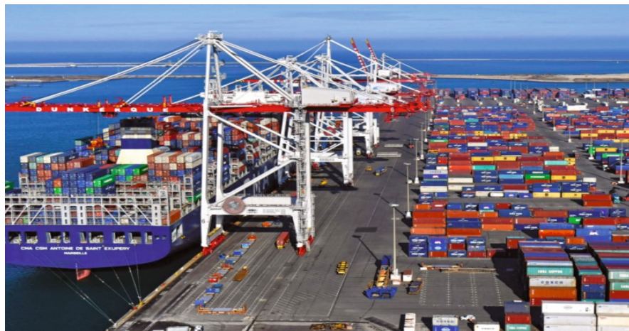
Figure III.13- Réalisation d'une plateforme portuaire (Port du Havre) .
