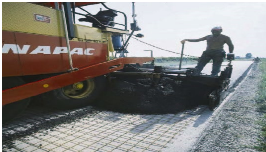
Figure III.8- Mise en place de treillis soudés
