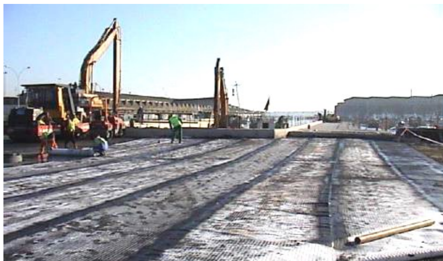
Figure III.11 : Projet d'insertion de géogridde au Port Lorient- Décembre 2001[49].
