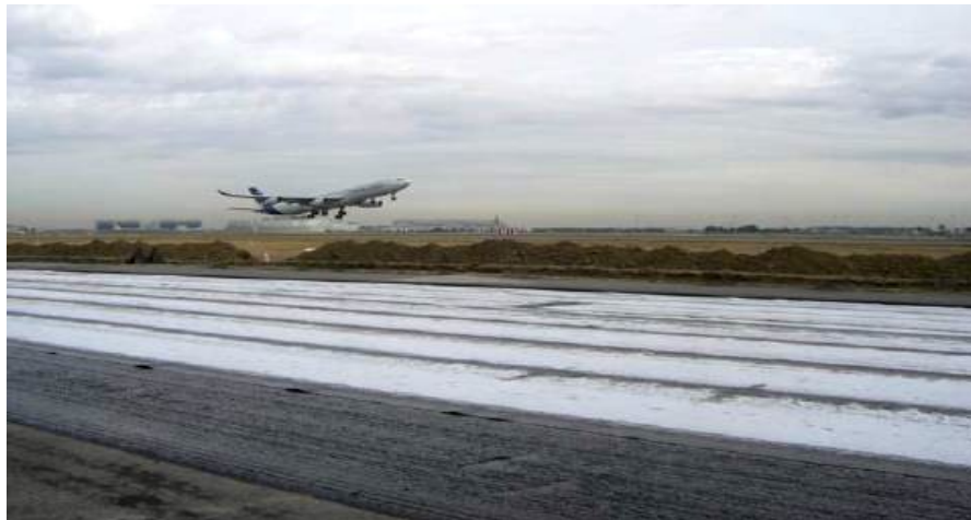
Figure III.12 : Placement de géogridde à l'Aéroport Toulouse Blagnac.
