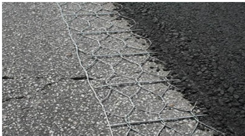
Figure III.9- MeshTrack : grille en acier tréfilé
