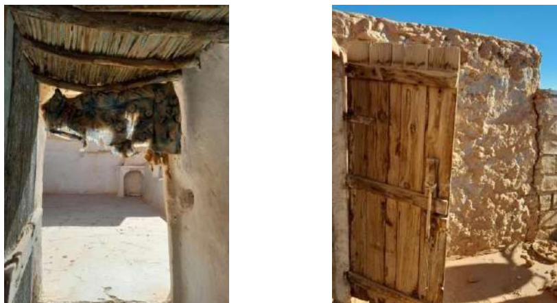
Figure 4.41: Porte d'entrée aux terrasses (Source : auteurs)
