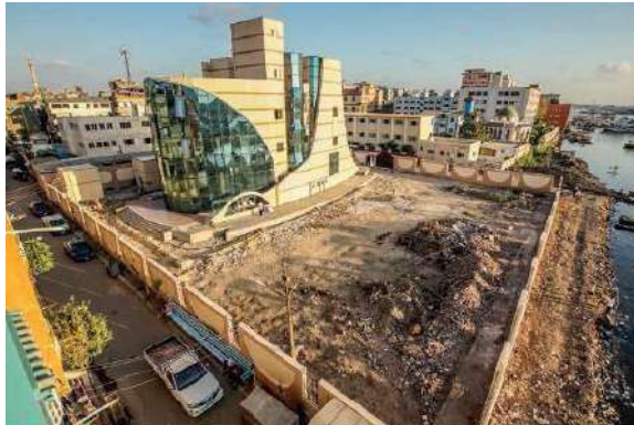
Figure 3.8 : Conditions existantes avant la mise en œuvre du projet
