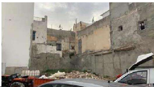
Figure 3.4 : La place de la Ruche avant l'intervention
