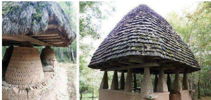
Figure 2.11 : Deux exemples d'architecture vernaculaire de réservoirs de stockage à Guilan, Iran, appelés Kouti [164].
