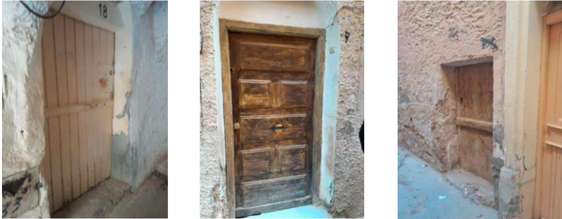
Figure 4.29: Portes d'entrée en bois (Source : auteurs)
