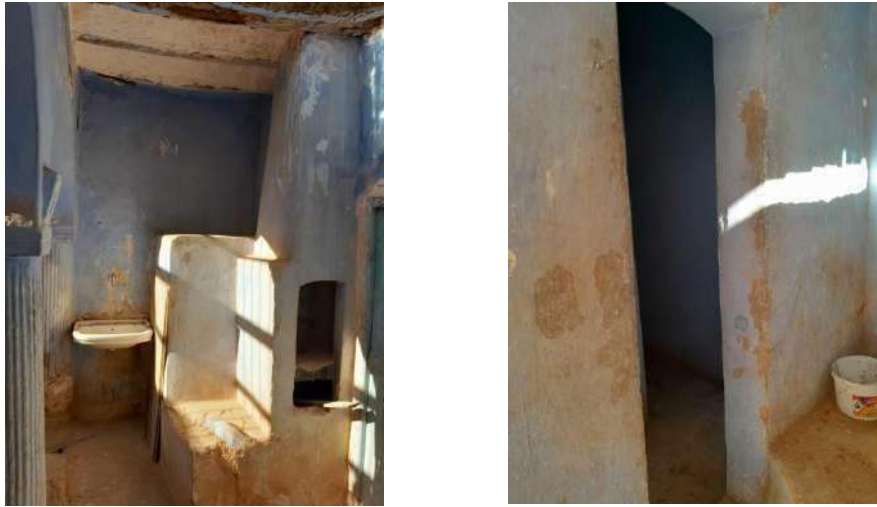
Figure 4.40: Des installations sanitaires au niveau d'une habitation traditionnelle mozabite (Source : auteurs)
