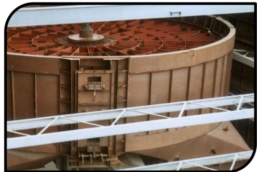
Figure IV.35 : Un échangeur rotatif à l'échelle industriel
