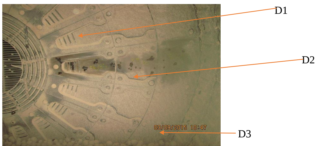
Figure 61 : mesure de l'épaisseur des plaques de cloison cote C2
