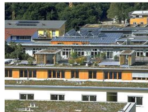
Figure 22: les toitures végétales du quartier Vauban
