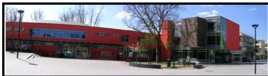
Figure 14: vue sur le forum Vauban
