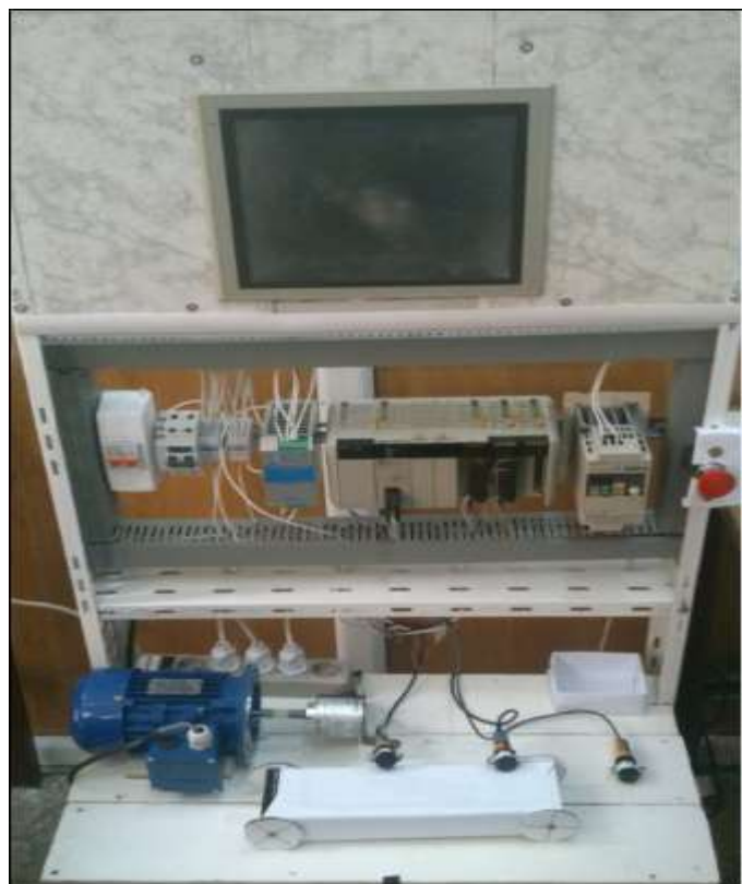
Figure 3.2 : Photo de la réalisation, les équipements utilisés.
