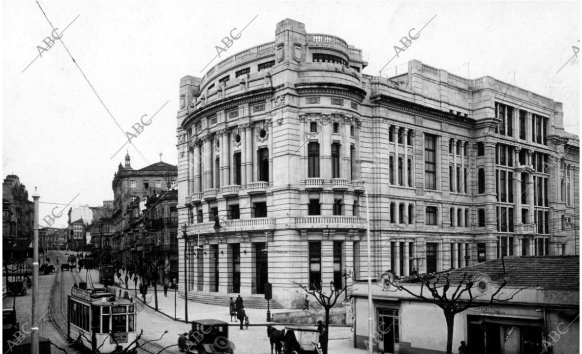
Figure I-1.39: Vue extérieure du théâtre Garcia Barbon, 1929.
