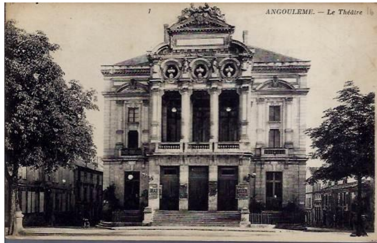
Figure I-2.27: Vue extérieure du théâtre d'Angoulême par Soudée.
