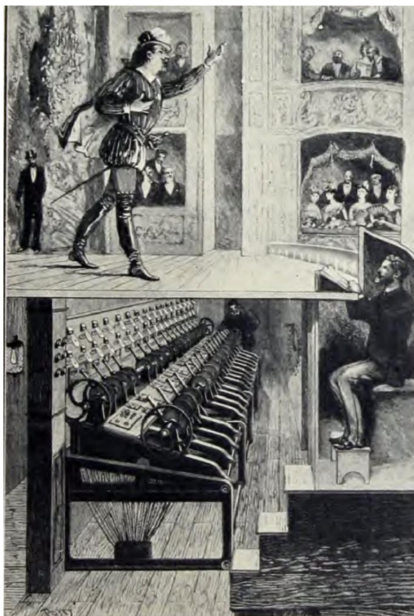
Figure II-1.32: Le rhéostat positionné au-dessous du plancher de la scène de l'Opéra de Paris.
