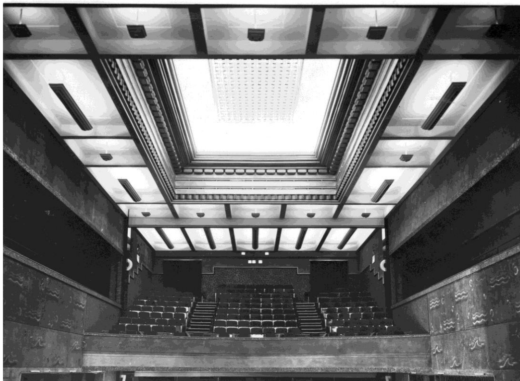
Figure II-1.50: Vue sur le plafond de la salle du théâtre de Bejaia.
