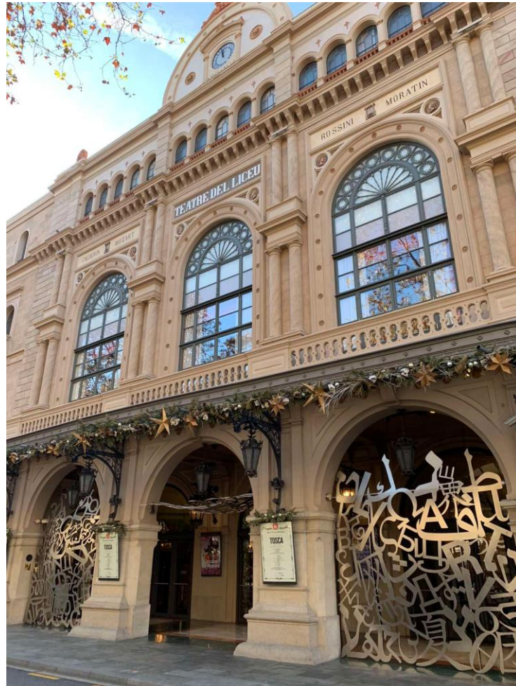
Figure I-1.37: Vue extérieure du théâtre du Liceu à Barcelone, 2022.
