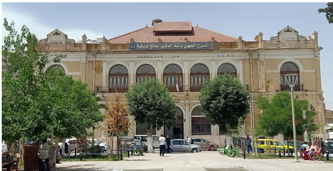
Figure I-3.26: Façade du théâtre de Batna (Mai 2021).
