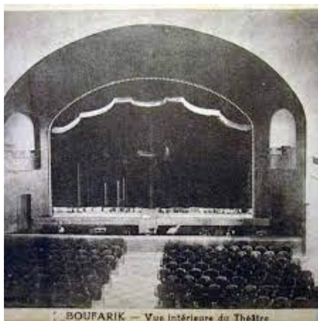
Figure I-3.48: Intérieur de la salle du théâtre de Boufarik.
