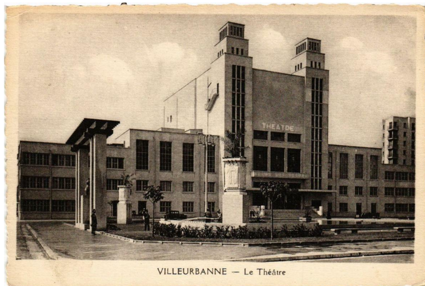
Figure I-2.40: Vue extérieure du théâtre de Villeurbanne.
