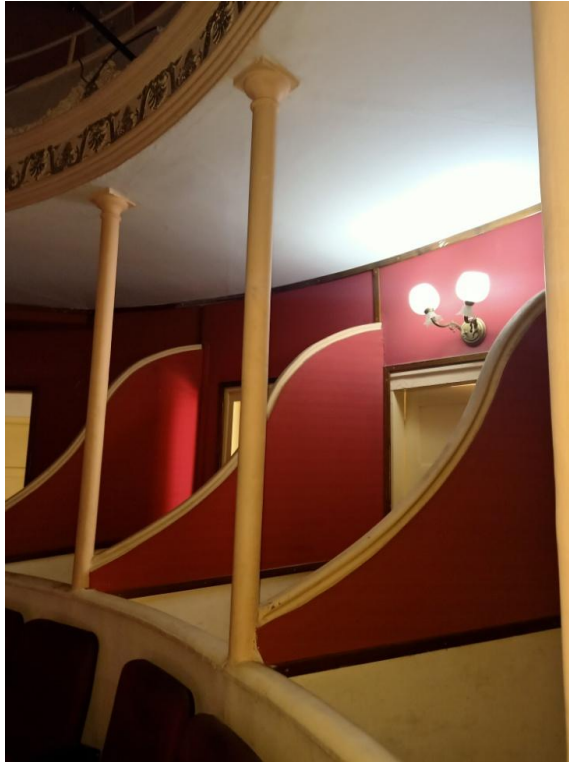
Figure II-2.29: Séparation des loges en col de cygne de la salle du théâtre de Sétif.
