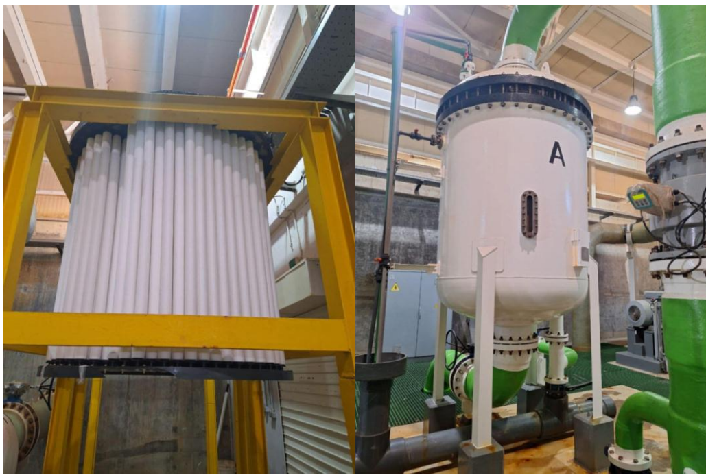
Figure .III.07: Les filtres à cartouches
