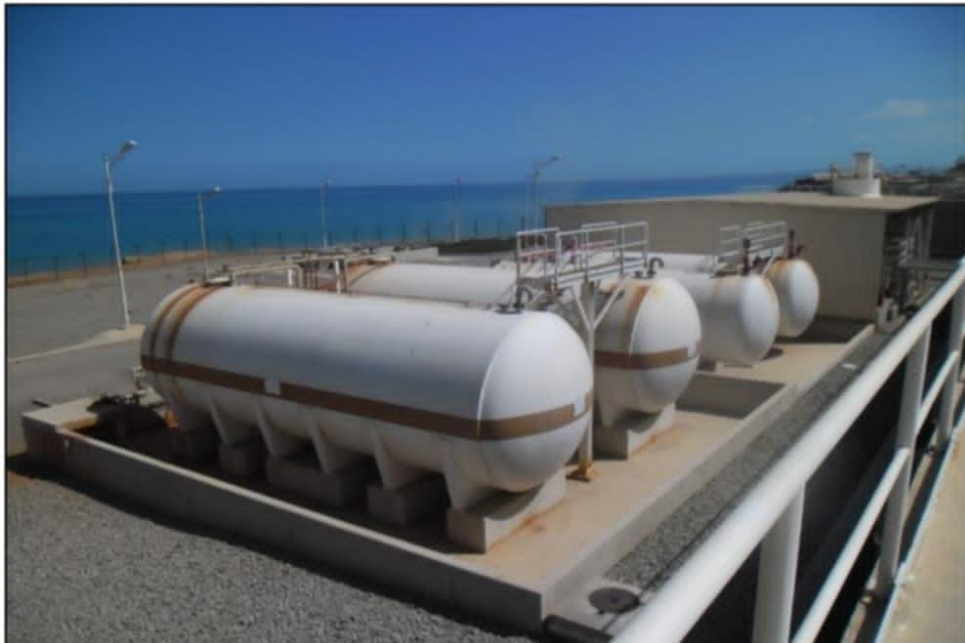
Figure .III.05: Réservoirs des produits chimiques
