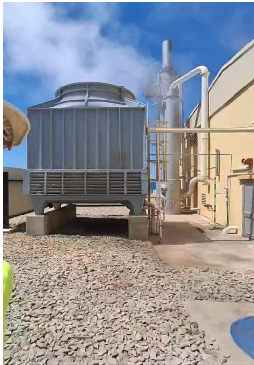
Figure .III.09: Bâtiment de CO2
