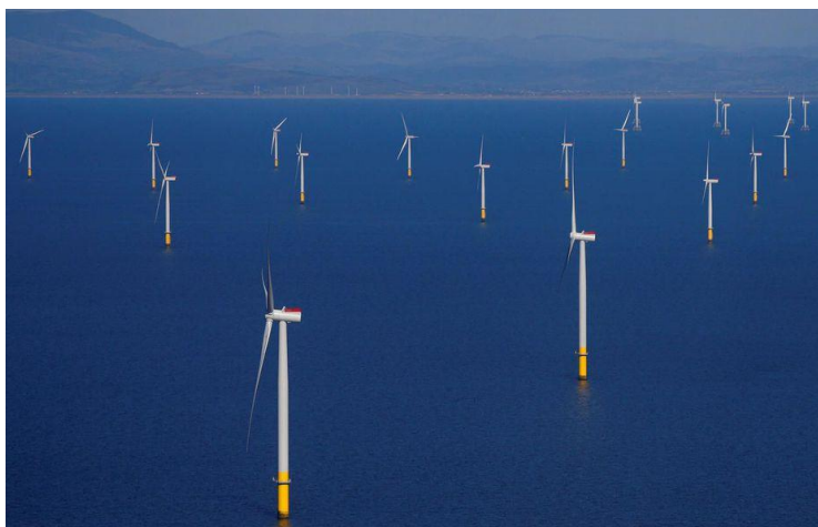
Figure IV.05 : Le premier parc éolien offshore France
