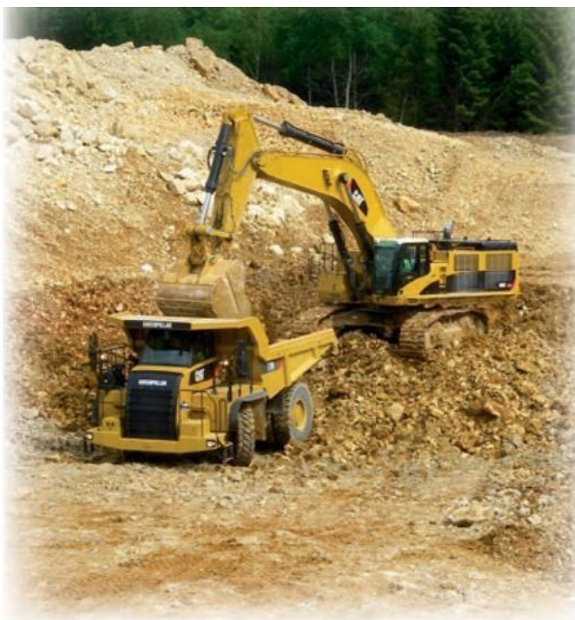
Figure 16 : Pelle en essai sur chantier
