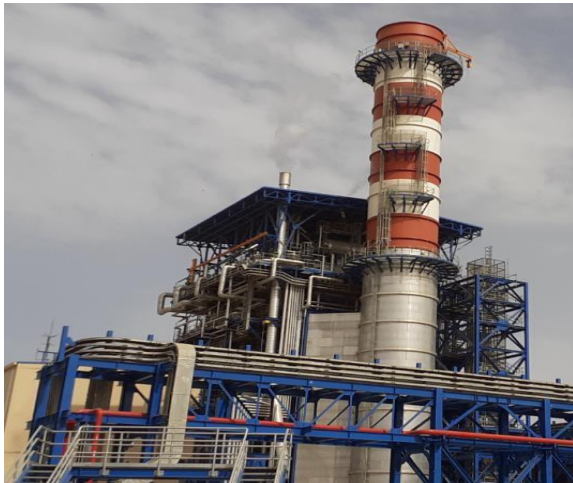
Figure I.3 : La chaudière de récupération
