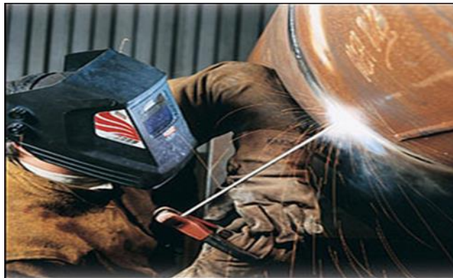
Figure 7 : Soudeur à l'électrode enrobée [09]
