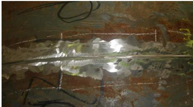
Figure 59:Meulage d'un cordon de soudure
