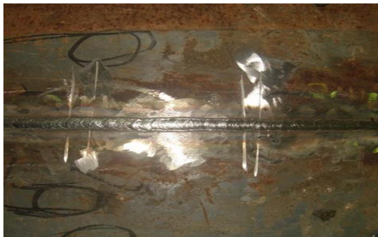
Figure 60:Rechargement du cordon de soudure.
