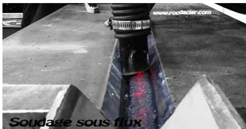
Figure 20: Photo du soudage sous flux [9]
