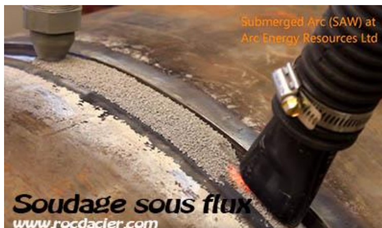
Figure 13 : Soudage sous flux [9]
