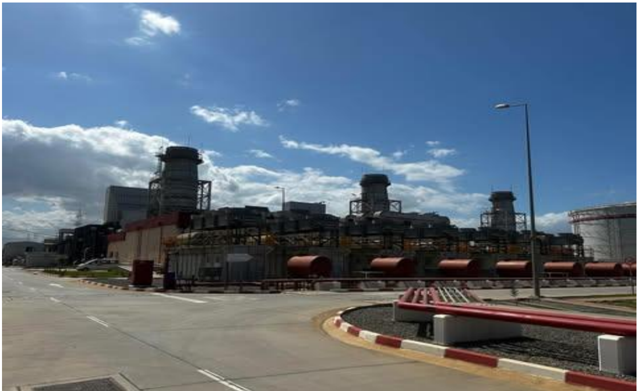
Figure. II.1: vue de la Centrale électrique.
