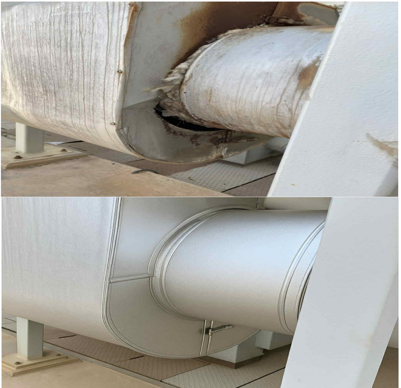
Figure. IV.3: Vanne IBH après et avant la maintenance
