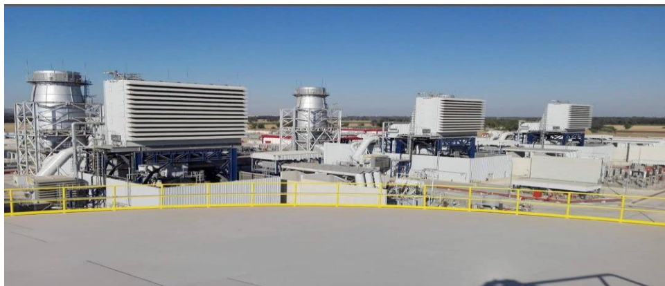
Figure(II.1) : représente le centrale électrique de Boufarik II
