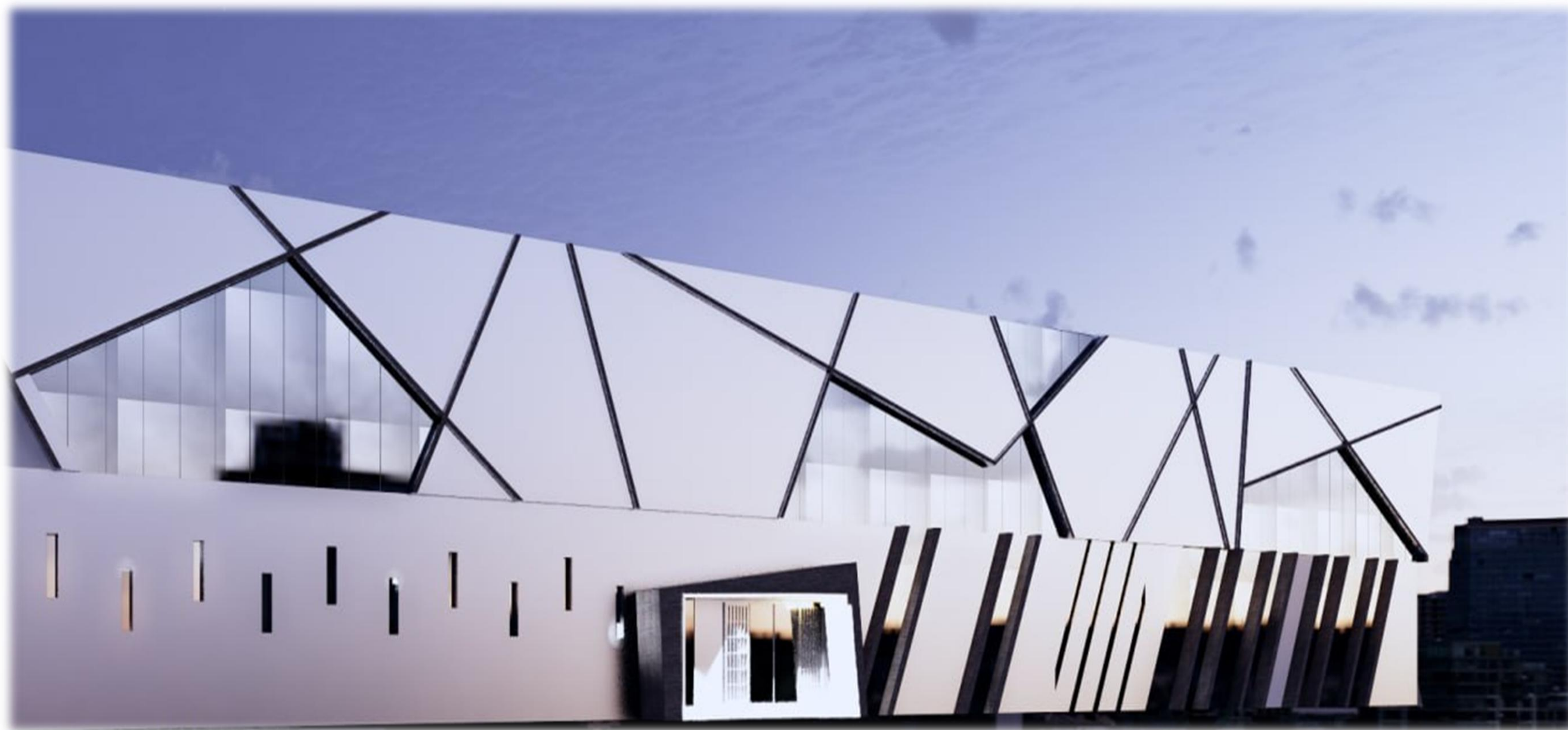
Figure 169 Salle de sport. Source : Auteurs.
