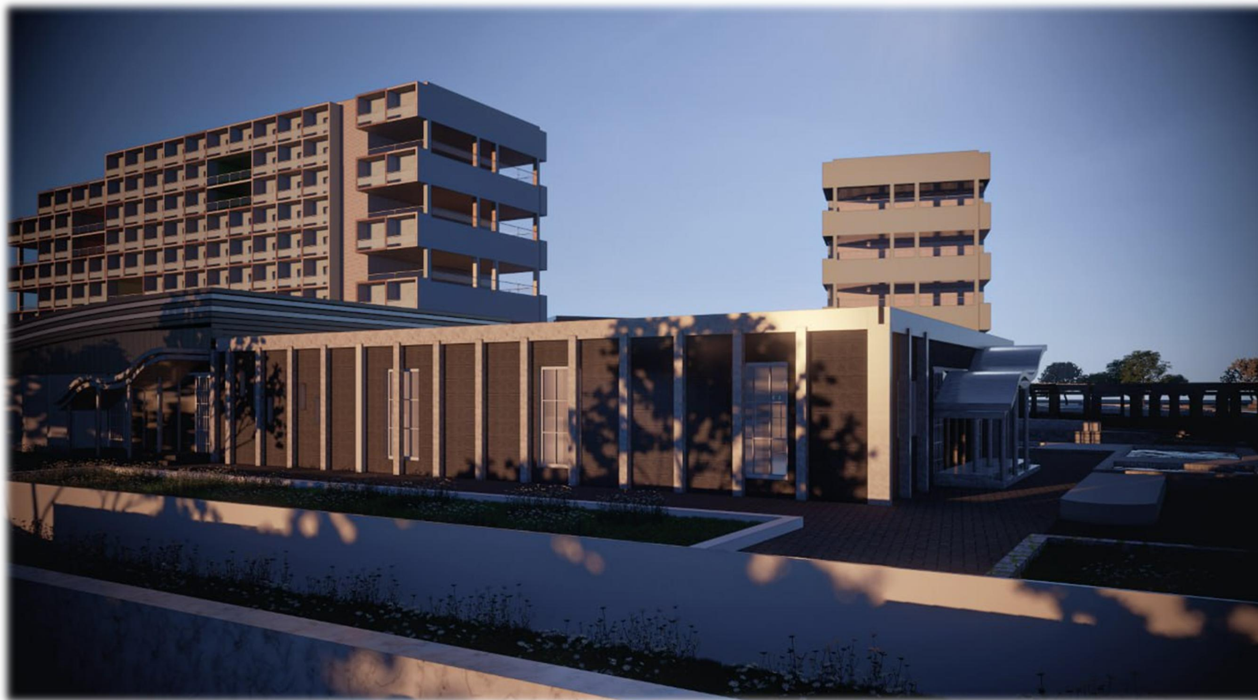
Figure 174 Aménagements extérieurs Source : Auteurs.
