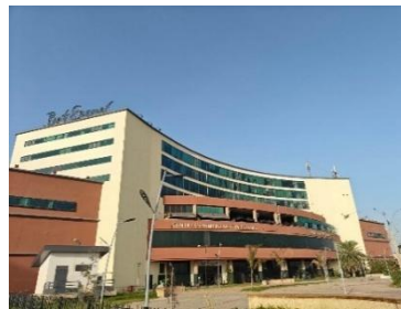
Figure 31: centre commercial Bab - Ezzouar /source les auteurs
