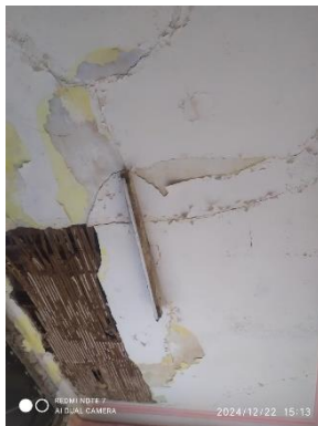
Fig :56,57,58 : effondrement de plancher source : auteur
