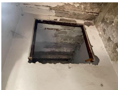
Fig :86,87,88 : infiltration d'eau source : auteur
