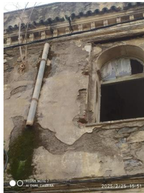
Fig :93,94,95,96,97,98 fissures source : auteur
