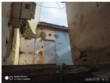
Fig :84,85: remontée capillaire source : auteur
