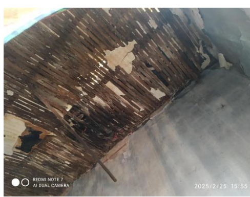
Fig :56,57,58 : effondrement de plancher source : auteur
