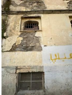
Fig :53,54,55 : dégradation de la pierre source : auteur
