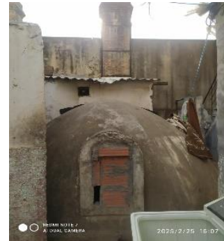
Fig 116vue sur la coupole de Hammam avant la réhabilitation
