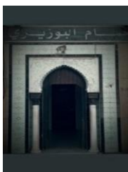
Fig 5 : Hammam bouziri source : hauteur
