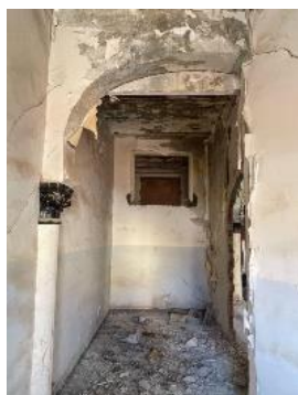
Fig :86,87,88 : infiltration d'eau source : auteur
