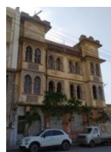
Fig 7 : Hammam Lkbayli source : hauteur
