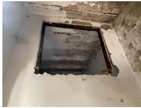
Fig :59,60 corrosion des profilés métallique source : auteur
