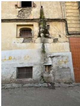
Fig :84,85: remontée capillaire source : auteur
