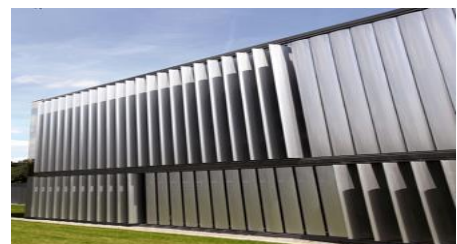
Figure 26:Les lames orientables et inclinables à 90° Source : Somefiventil 2024
