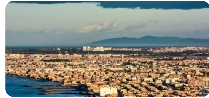
Vue Aérienne Source: Google
