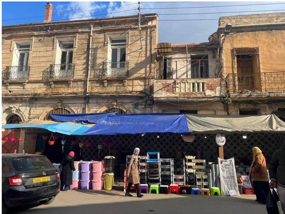
Figure 202: exemple d ' une façade de la rue Didouche Mourad
