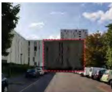
Figure 56: Vue des bâtiments démolis Rue Henri Matisse
