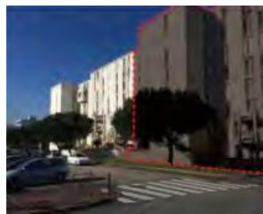
Figure 58: Vue des bâtiments démolis Rue 8 Mai 1945
