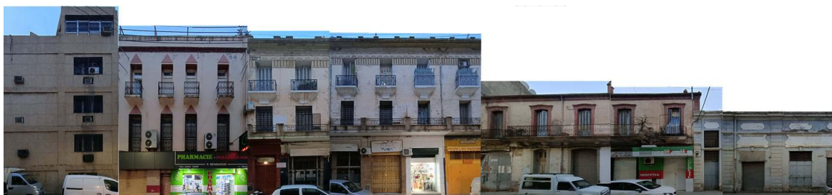
Figure 192:Façade sur la rue Didouche Mourad
