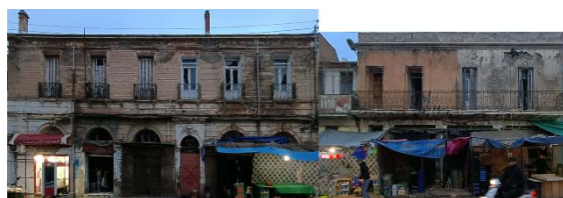
Figure 191: Façade sur la rue Didouche Mourad
