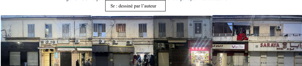
Figure 194:Façade sur la rue Didouche Mourad
