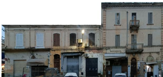
Figure 196:Façade sur la rue Didouche Mourad
