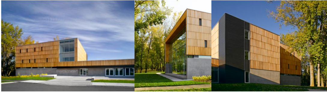
Figure 88: Les vues extérieures de la bibliothèque
