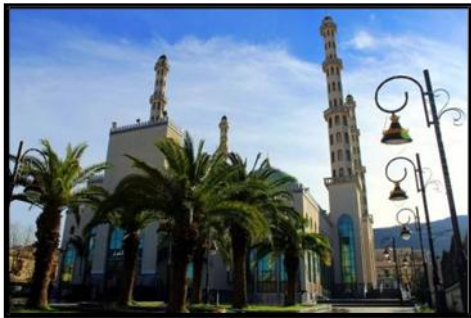
Figure 129: place de mosquée El Kaouthar
