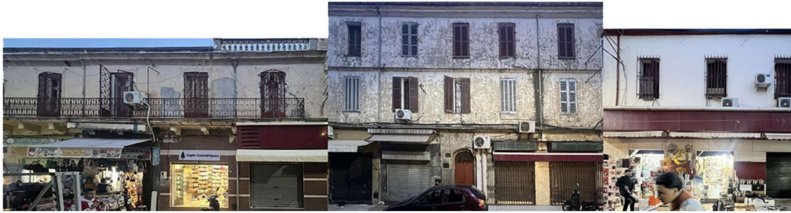
Figure 198:Façade sur la rue Didouche Mourad
