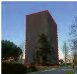
Figure 57: Vue des bâtiments démolis Rue Antoine Watteau
