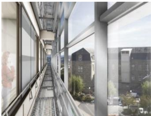
Figure 27: façade double peau Source : cahiers-techniques-batiment.fr
