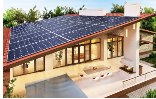
Figure 44 Panneaux Solaire. Source : https://www.connaissancedesenergies.org/
