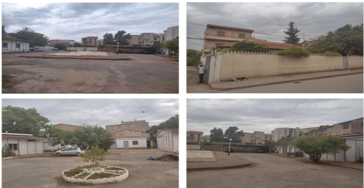
Figure 26 Images De Terrain D'intervention. Source : Auteur
