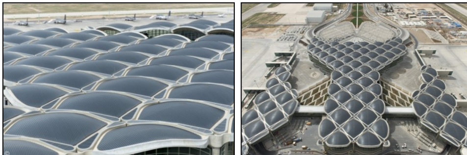
Figure 28 : la toiture convexe du projet aéroportuaire QAIA
