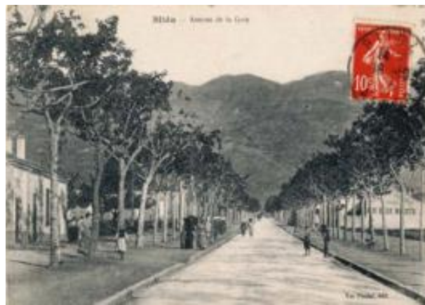
Figure 68 : Avenue de la gare de Blida
