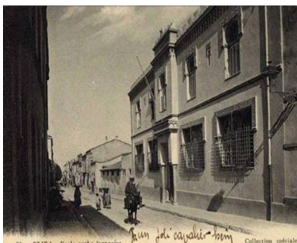
Figure 73 : : Lycée Ibn Rachad (ex : Duveyrier) collège
