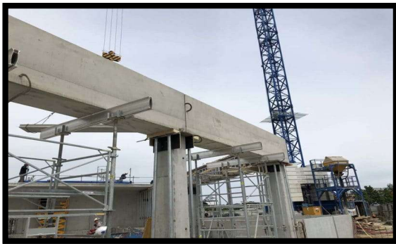
Figure 70: Système portique en béton armé simple
