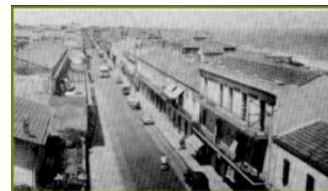
Figure 66 une vue sur la RN11.source: Calaméo.
