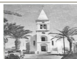
Figure 59 église de Saint Roche. Source : Calaméo.
