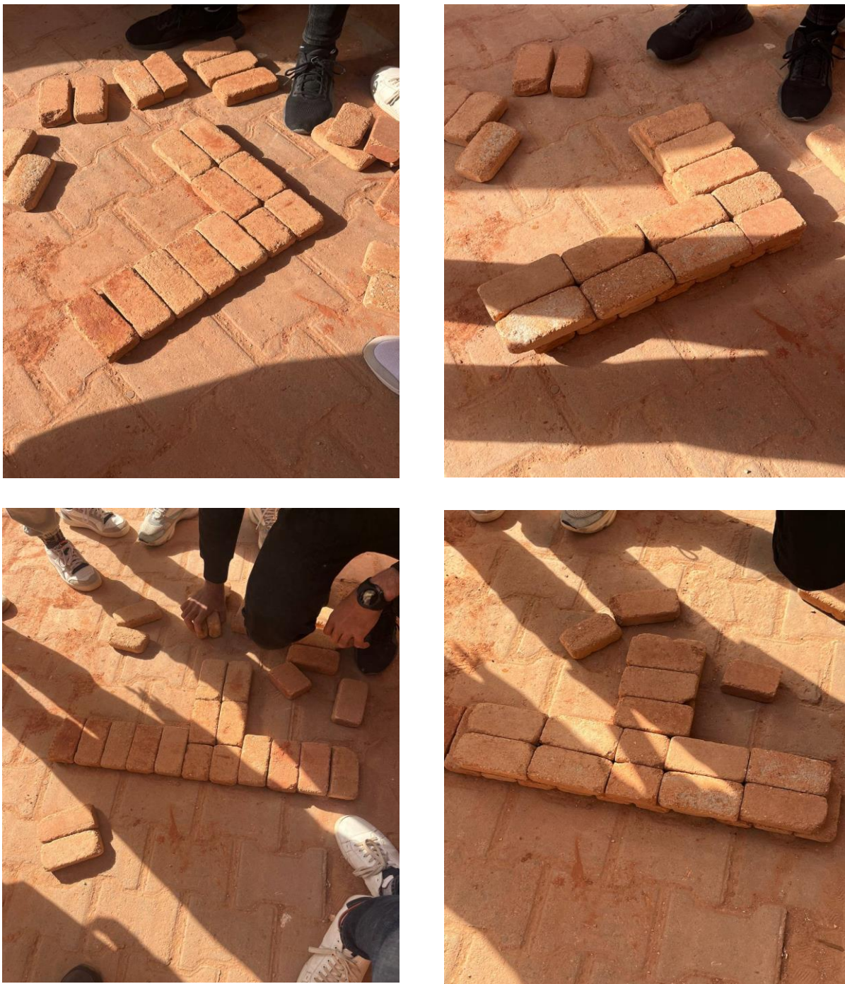
Figure 30 Pratique d'assemblage des mur en BTC en formation de CAPTERRE , prie par les auteurs
