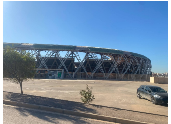
Figure 58 : façade de stade
