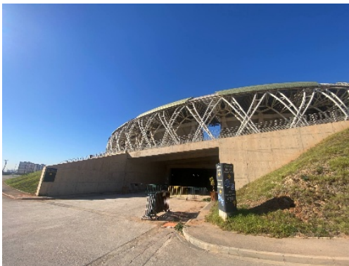
Figure 62 : accès secondaire pour la partie technique
