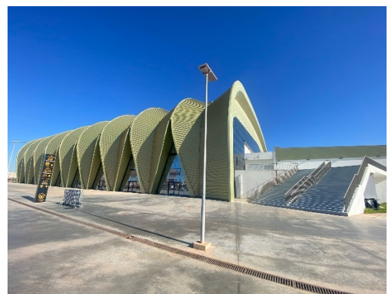
Figure 67 : photo façade latérale de la salle omnisport
