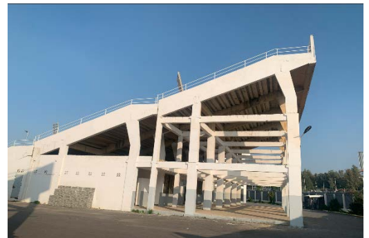
Figure 83 : photo des gradins
