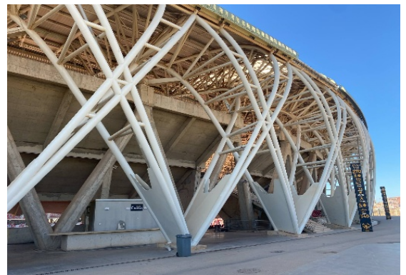
Figure 59 : façade de stade
