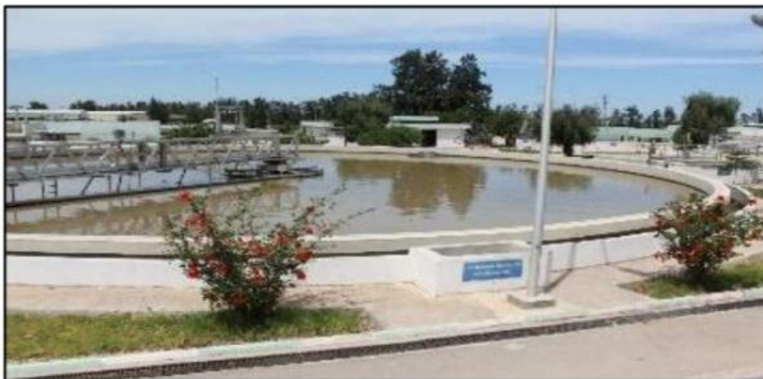
Figure 15: Décanteur primaire de la STEP de Béni Mered (Originale, 2025).
