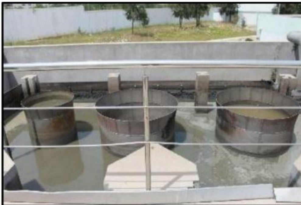
Figure 11: Bâche d'arrivée (Originale, 2025).
