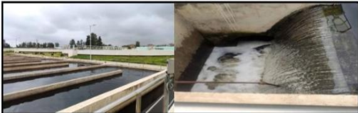
Figure 19 : Bassin de désinfection à chicanes (Originale, 2025).
