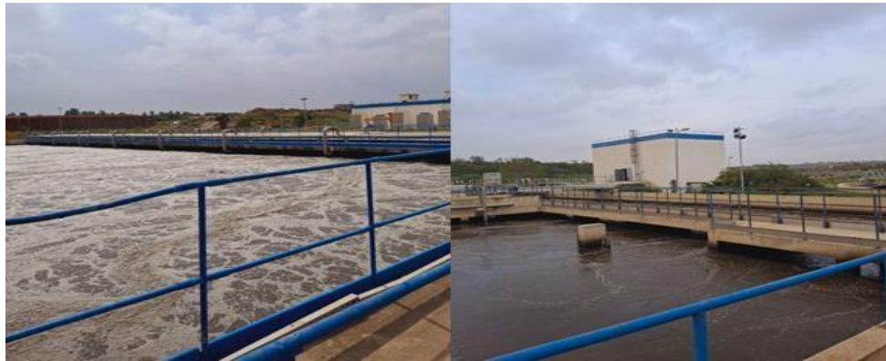
Figure 8 : Bassin biologique ou d'aération (photo originale)
