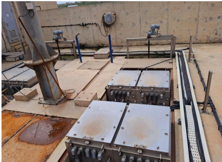
Figure 11 : Désinfection physique par UV (photo originale)
