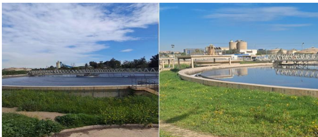
Figure 7 : Décanteur primaire (photo originale)
