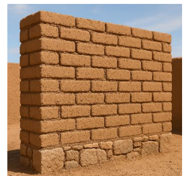
Figure 129 : mur porteur en adobe, auteur
