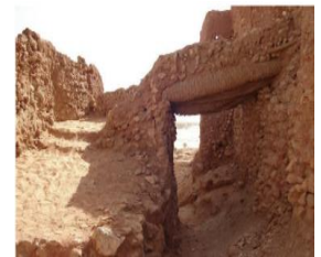
Figure 81 : les murs de ksar de Tamassakht, auteur
