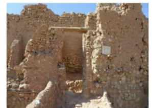
Figure 80 : entrée de ksar de Tamassakht, auteur
