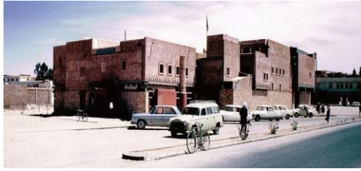
Figure 150 : l'Hôtel des postes de Ghardaïa
