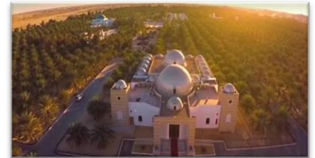
Figure171 : vue de l'extérieure complexe la gazelle d'or
