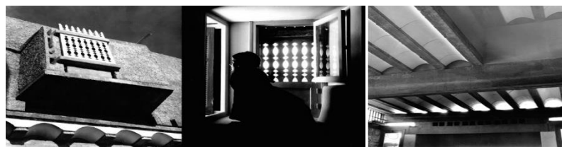
Figure 153 : les moucharabiehs dans l'Hôtel des postes de Ghardaïa et le toit traditionnel
