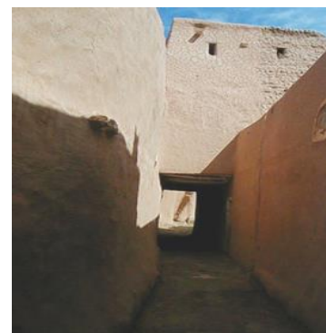
Figure 24 : Darb (rue centrale) Ikhrizam à Boussemghoun
