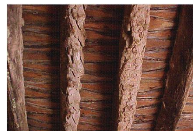
Figure 34 : Gaines de palmier juxtaposées à Taghit
