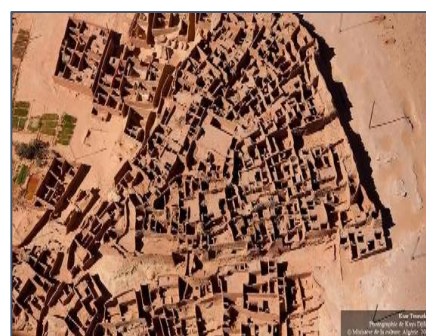
Figure 69 : Le ksar de Tamassakht, google image
