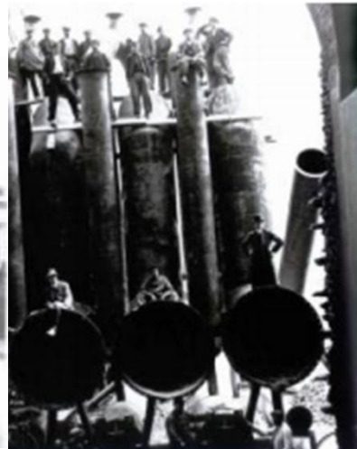
Figure 4 : les conduites forcées 17
