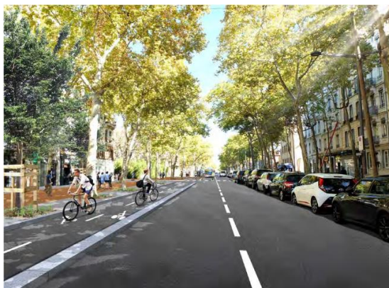
Figure 11: Boulevard de la Croix-Rousse - existant – Regard vers l'est depuis l'ouest de la Mairie Source : jeparticipe.grandlyon.com
