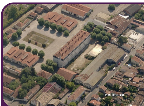
Figure 9 : Photo aérienne avant la réhabilitation source : -2019LIVRET-BastideNiel-planches
