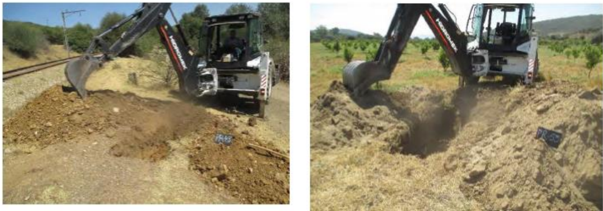
Figure 3.2 : Exécution de puits de reconnaissance à l'aide d'une tractopelle.
