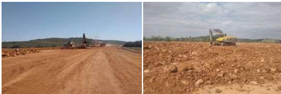
Figure 1.1 : Préparation de remblais sur sols compressibles. [5]
