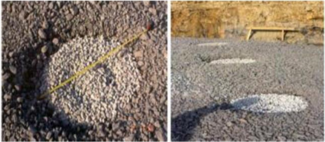
Figure 1.8 : Colonnes ballastées réalisées par voie sèche.[6]
