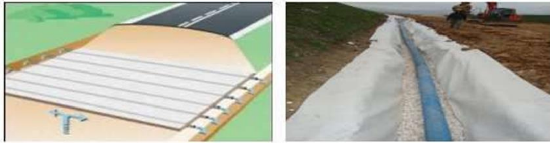
Figure 1.20 : Utilisation des géotextiles pour le drainage. [5]
