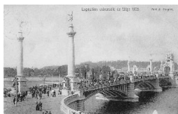
Figure 10 : Pont de Fragnée
