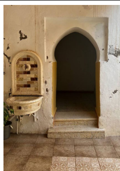
Figure 229: Façade principale Source : Auteure
