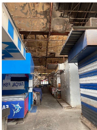
Figure 288 : L'intérieur du marché Yakoub Turki Source : Prise par l'auteur
