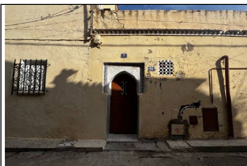
Figure 227: Façade principale Source : Auteure
