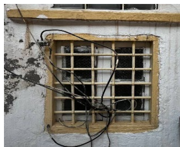
Figure 223: : Détail de fenêtre Source : Auteure
