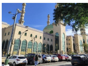
Figure 173: Mosquée EL Kaouthar Source : Auteurs.
