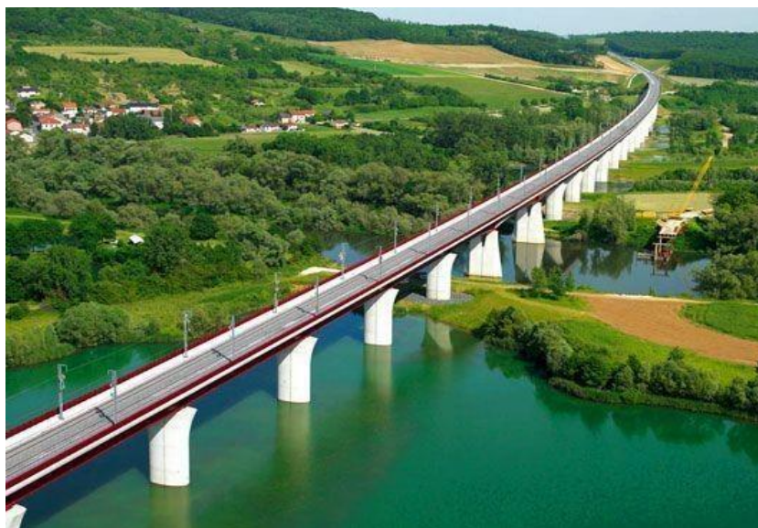
Figure I. 7 Viaduc traversant un barrage
