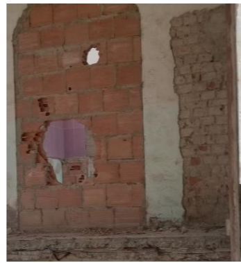
Figure 43: Photo qui montre les murs en brique. Source : Auteur.
