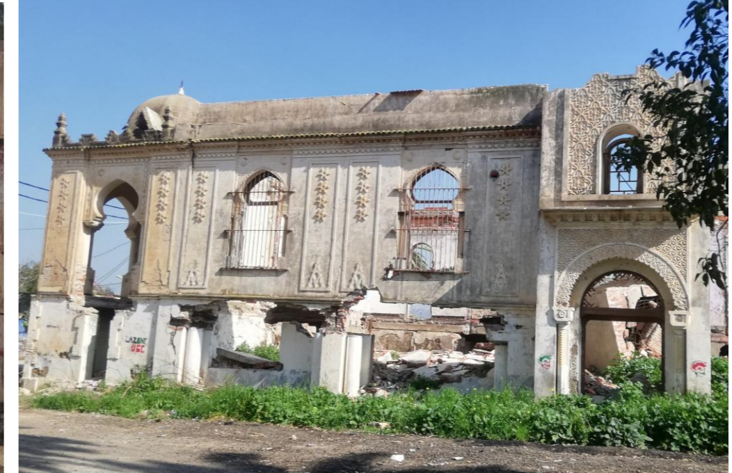
Figure 72: Ouverture façade ouest
