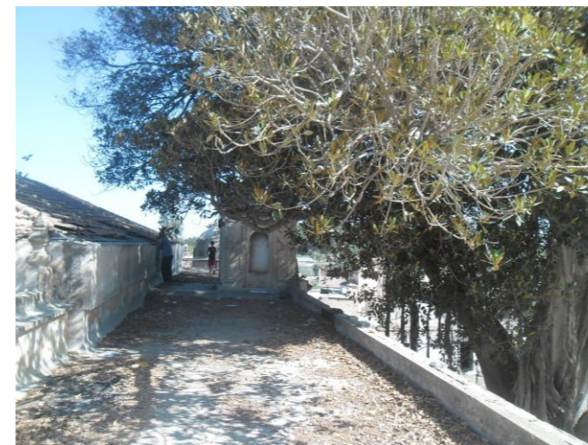
Figure 41: Vue depuis la terrasse sur la toiture. Source : BET Handassa wa Bina, 2017.
