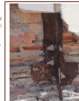
Figure 50: Photo de poteau métallique ancré dans le mur. Source : Auteur.
