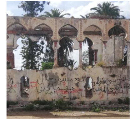
Figure 41 : Façade Est. Source : Auteur, 2025.
