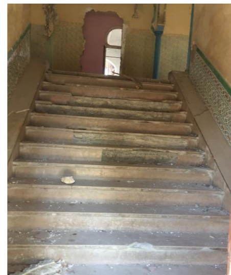
Figure 27: Escalier de l'entrée ouest. Source: BET Handassa wa Bina, 2016.
