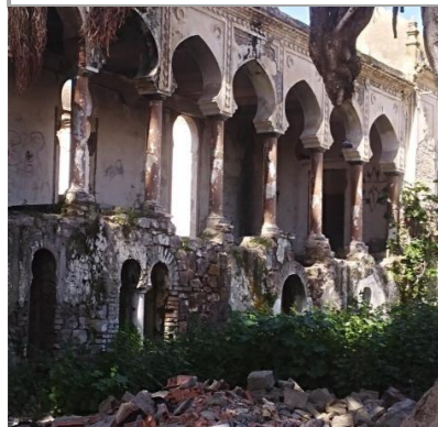
Figure 48: photo qui montre les murs en moellon de pierre. Source : Auteur.
