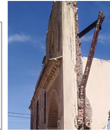
Figure 42: photo qui montre les éléments métalliques. Source : Auteur.
