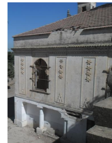
Figure 41: Vue sur la toiture. Source: BET Handassa wa Bina, 2017.
