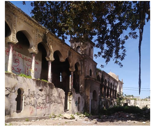
Figure 41: Façade Est. Source : Auteur, 2024.
