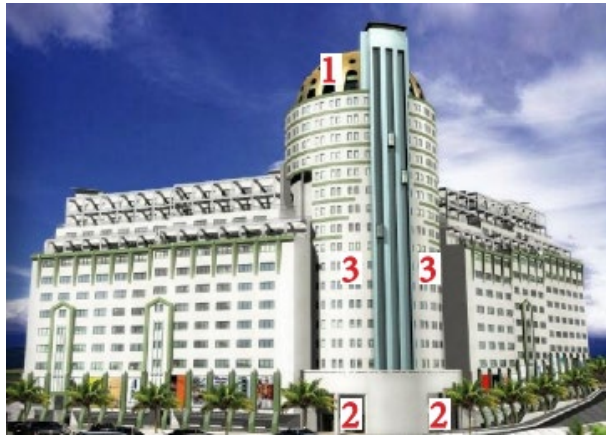
Figure 106 la façade de centre commercial el Qods
