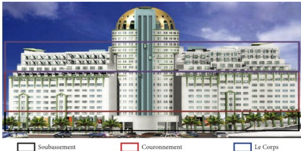
Figure 107 la façade de centre commercial el Qods
