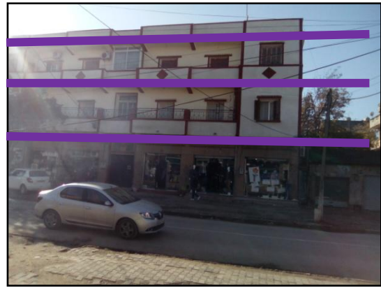
Figure 3.36 : Façade d'une maison au boulevard Mohamed El-Arbi.
