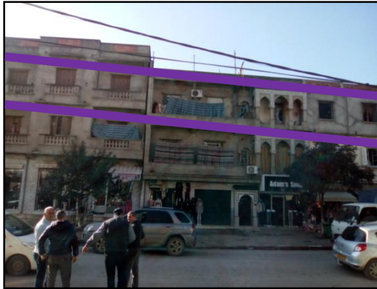
Figure 3.35 : Façade d'une maison au boulevard Mohamed El-Arbi.
