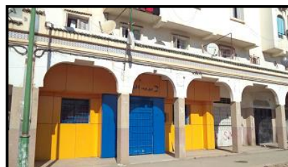
Figure 3.24 : Le quartier d'habitat collectif près de Diar El-Baraka de Baraki.
