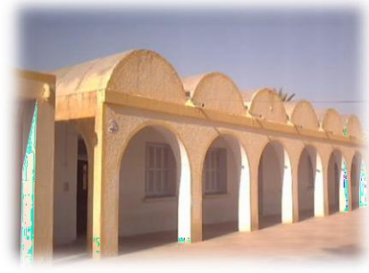
Figure .18. Photo sur voûtes Source : photo personnelle
