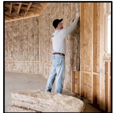
Figure 19:isolation de mur par la laine de verre.source: Tout savoir sur l'isolation thermique Rénovation énergétique et économies d'énergie | Castorama.fr
