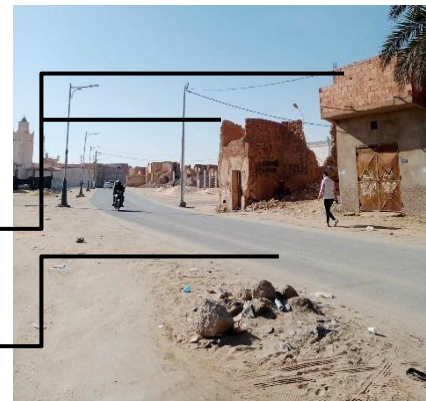
Figure 43: rupture physique et temporelle entre les 2 différents tissus ; source : auteur
