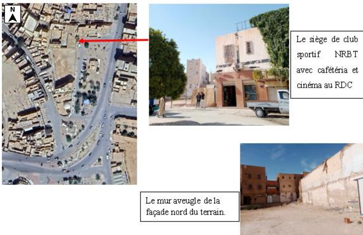
Figure 100 : images de ce qui limite la façade nord du terrain du projet d'hôtelier avec leurs emplacements au niveau de la vue aérienne; source : auteur
