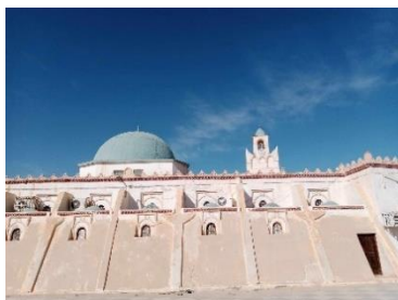
Figure 2 : Mosquée El Atik (patrimoine nationale en 2016) source : auteur
