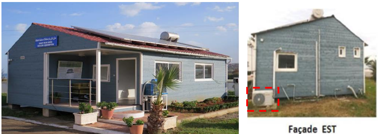
Figure 24: Vue extérieure de la maison solaire expérimentale de l'UDES et positionnement du climatiseur sur la façade Est.
