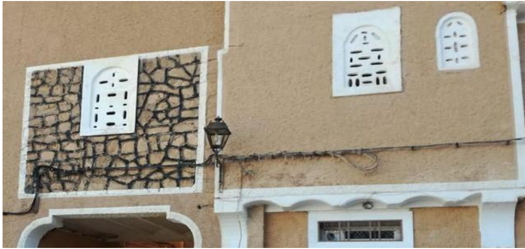
Figure35: Revêtement extérieur de façade
