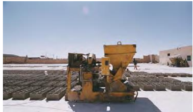
Figure37 : les machines de construction
