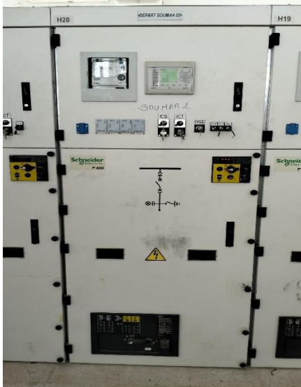
Cellule SCHNEIDER 30kv
