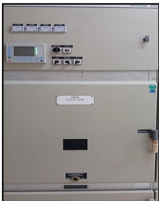
Figure 2.12.c : Cellule couplage
