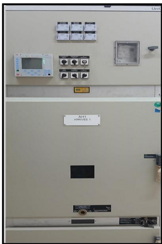
Figure 2.12.a : Cellule d'arrivée
