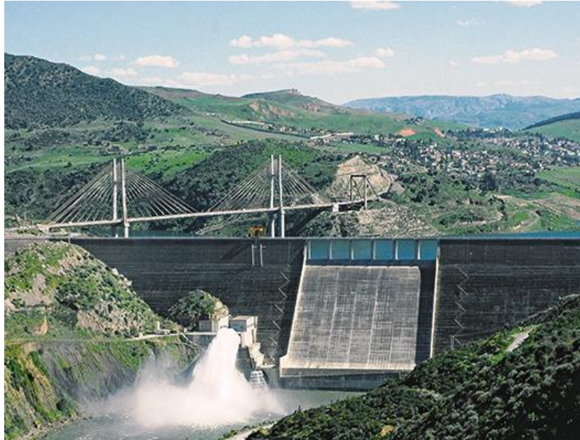
Figure 6 : vue sur barrage BH (Evacuateur de crue) (ANBT).2017
