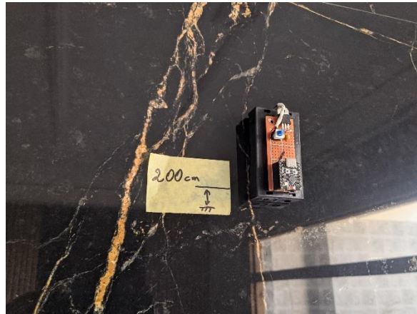
Figure IV.21 : Installation d'une balise ESP32-C3.
