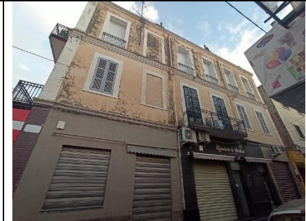
Immeuble d'angle à deux façades Hauteur : R+2 RDC réservé aux commerces, les étages aux logements.
