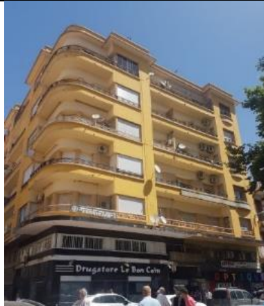
Immeuble de M. Melis (1930) Malhonda et Garagnon
