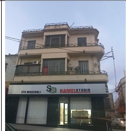
Immeuble d'angle à deux façades perpendiculaires Hauteur : R+2
