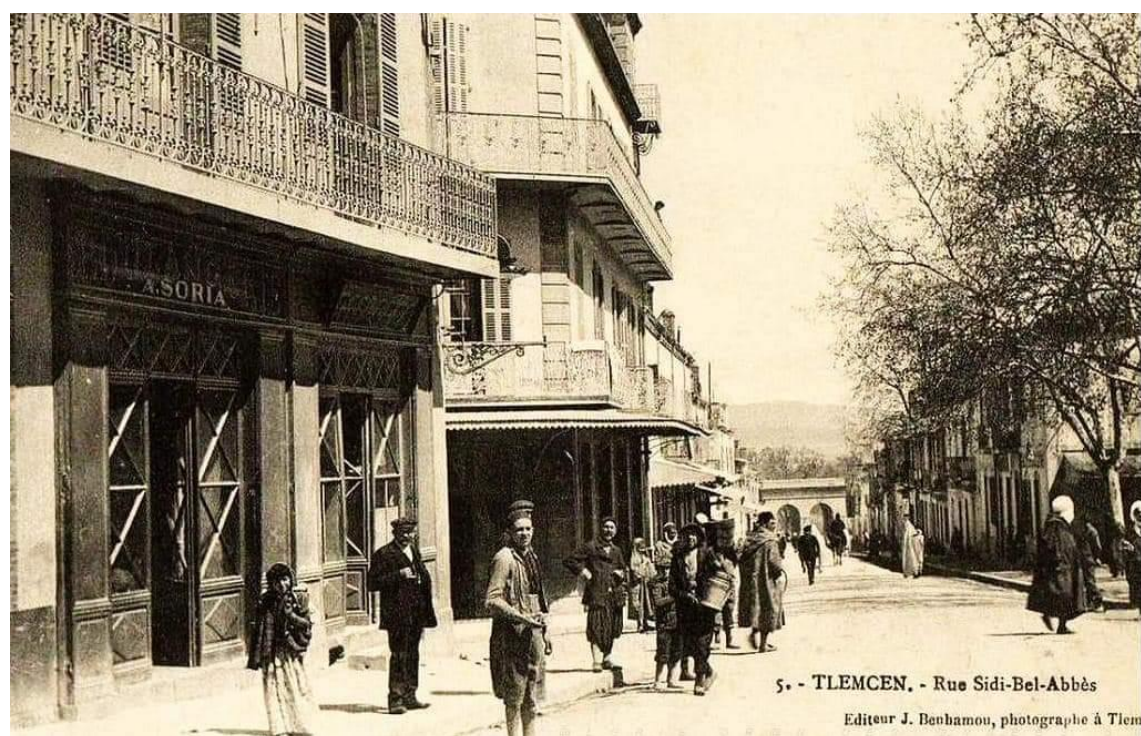
Figure 141: boulevard 1er novembre 1954 ex rue de Sidi Bel Abbès
