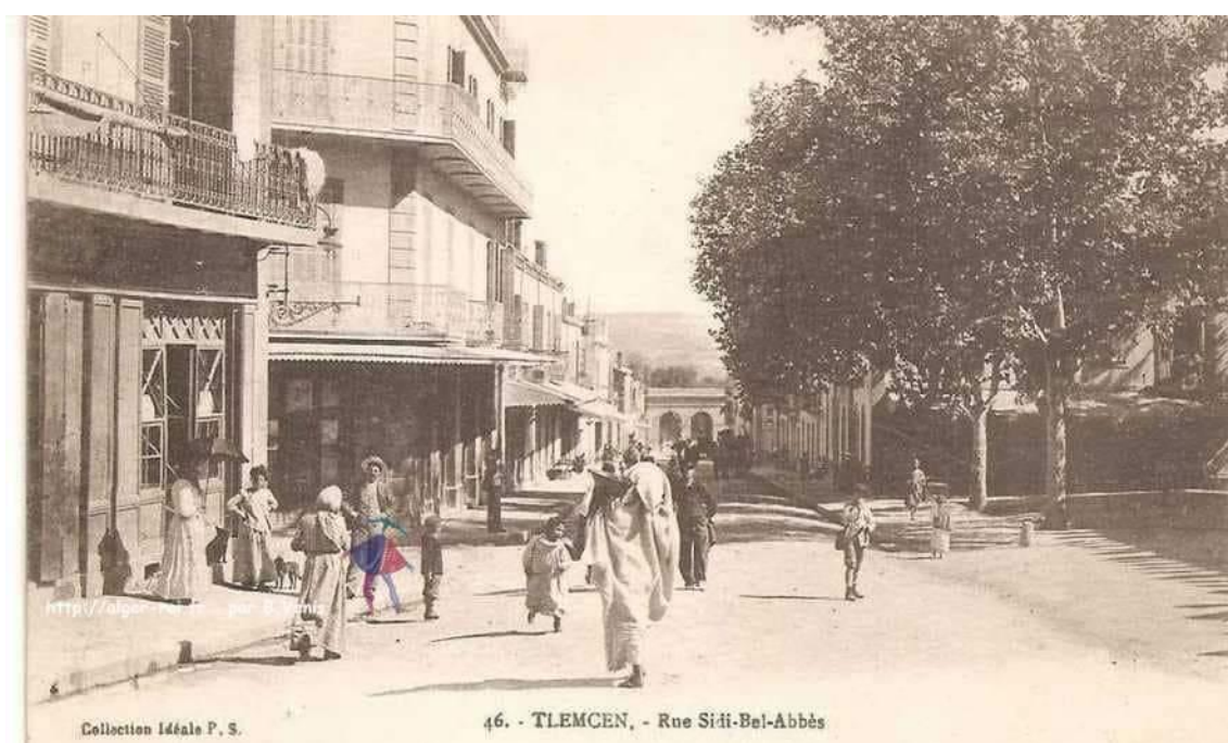
Figure 142: Boulevard 1er novembre 1954 ex rue de Sidi Bel Abbès
