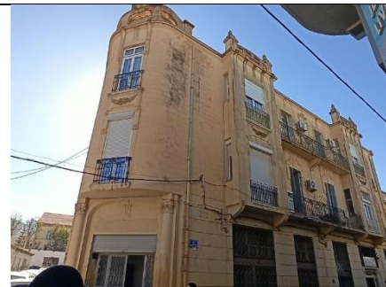
Immeuble d'angle à deux façades Hauteur : R+2 RDC réservé aux commerces, les étages aux logements.
