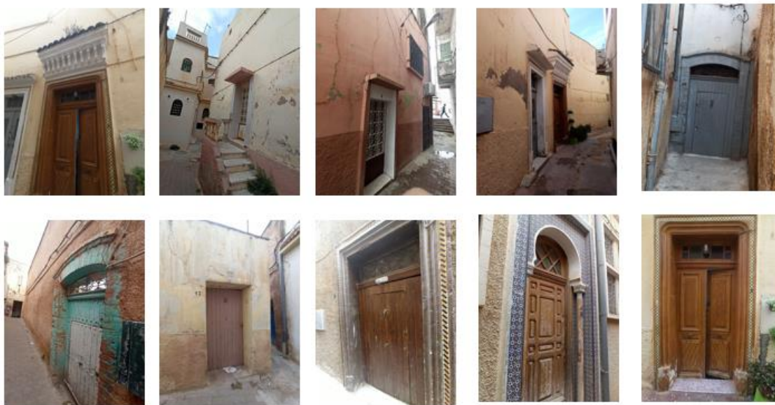
Figure 32: Accès aux maisons traditionnelles dans la médina de Tlemcen (source : auteure, 2022)
