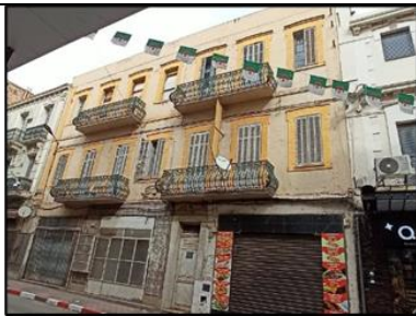
Immeuble situé à la rue de France
