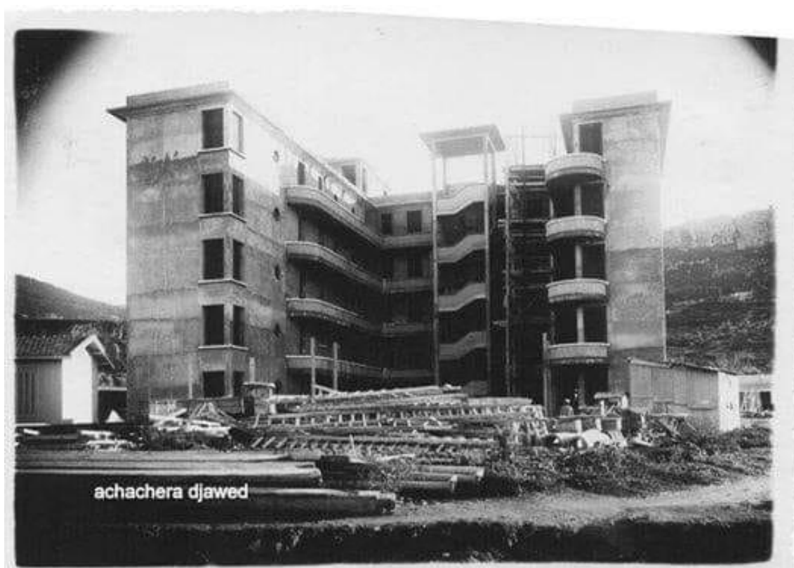
Figure 138: chantier de l'immeuble HBM de Sidi Chaker (source : collection Achachera Djawed)
