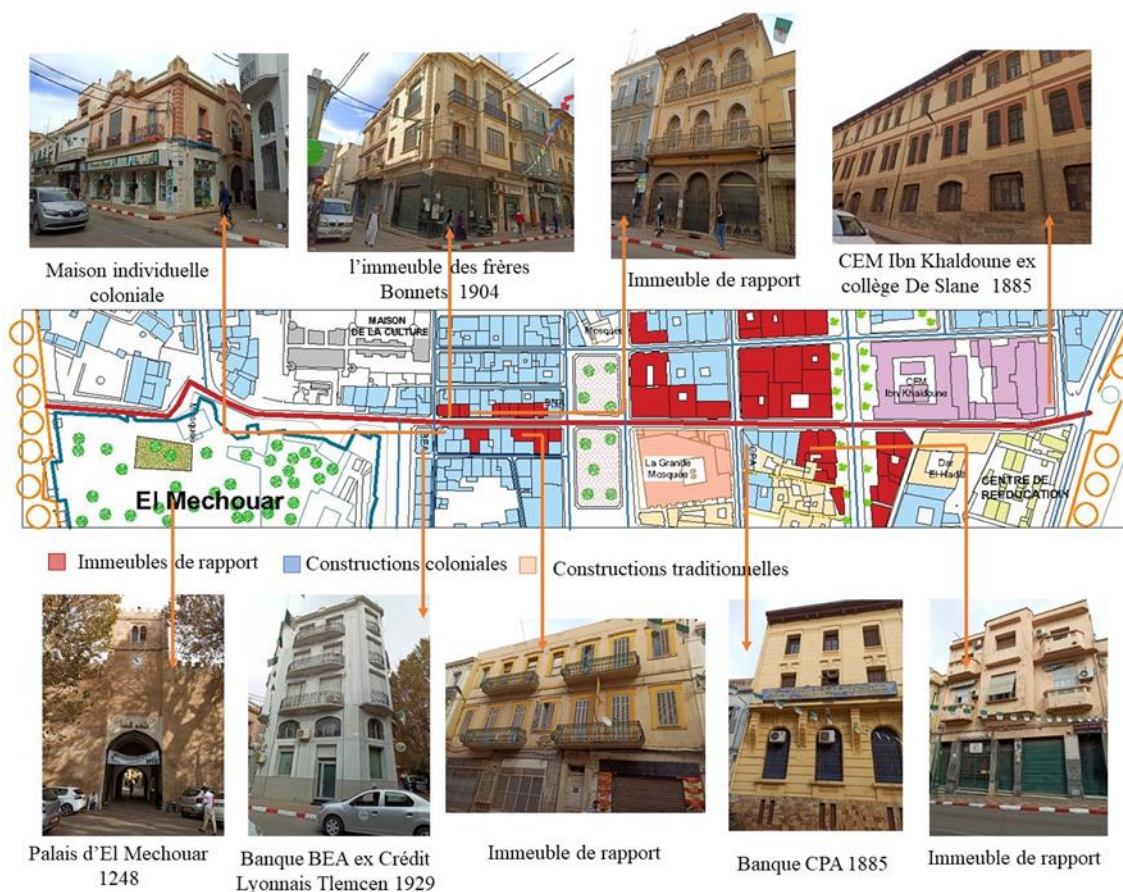
Figure 29: Rue de France (source : auteure, 2023)
