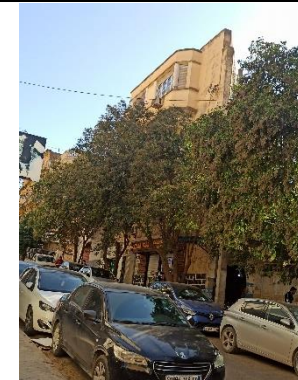
Immeuble à deux façades Hauteur : R+3 RDC réservé aux commerces, les étages aux logements
