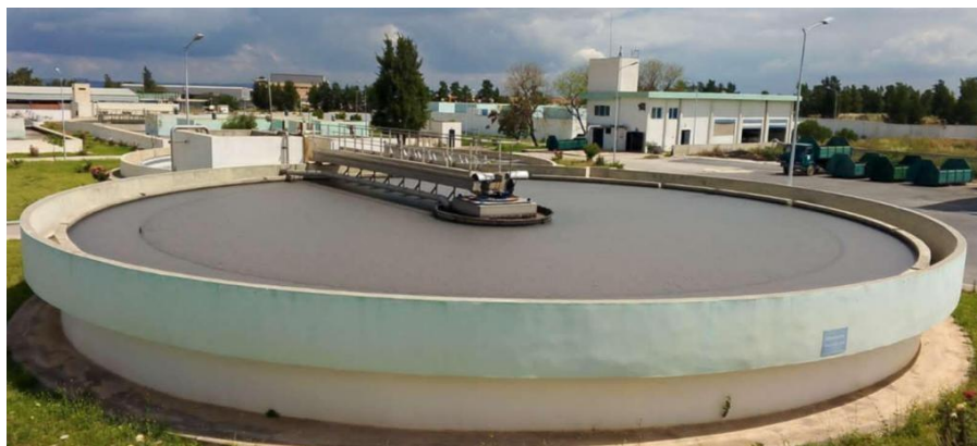
Figure 1 : Bassin de décantation Primaire (photo origine . 2025)
