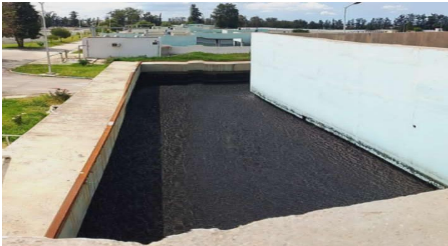
Figure 2: Bassin de décantation secondaire (photo origine 2025)
